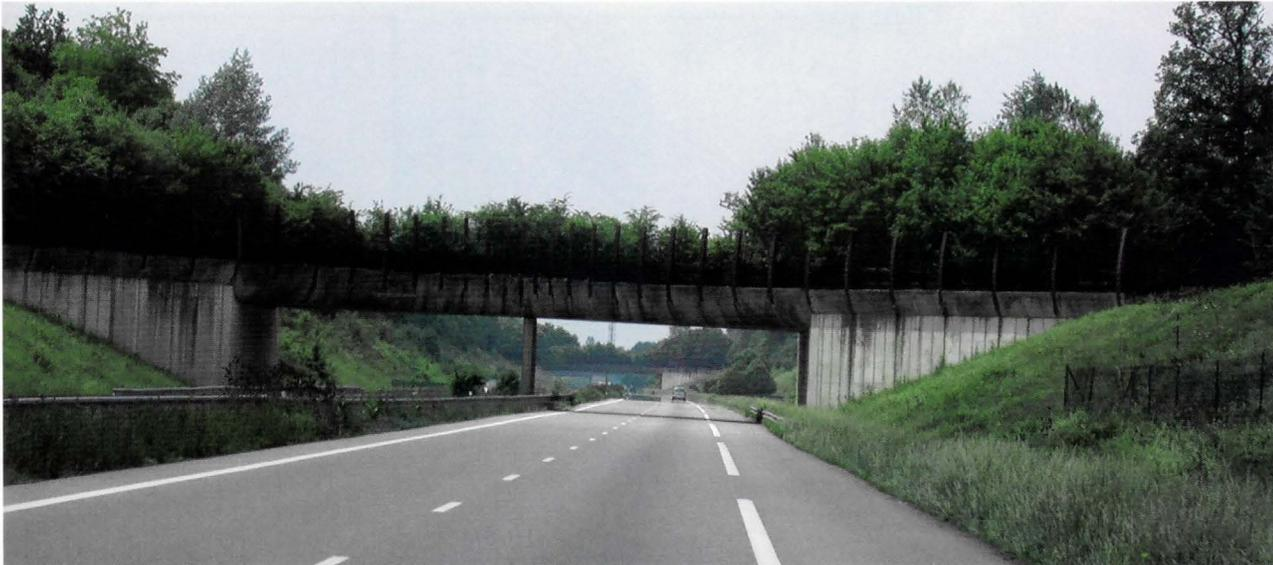
**Abbildung 7:** Wildbrücke bei Mulhouse im Elsass. Derartige Bauwerke sind inzwischen bei neuen Autobahnen verpflichtend, auch wenn sie mit hohen Kosten verbunden sind. Bei bestehenden Autobahnen werden sie jedoch nur selten nachträglich etabliert (Foto Beierkuhnlein).
